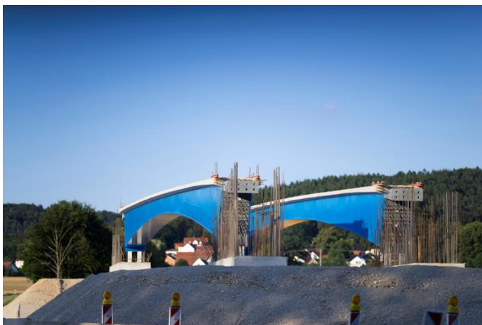
Bild 2) Längsträgerduett vor Verbindung mit Widerlagern. Bildnachweis: Reinhard Mederer
