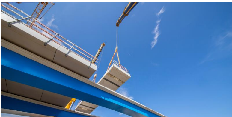
Segmentbrücke Bögl Bildnachweis: Firmengruppe Max Bögl / Segmentbrücke
