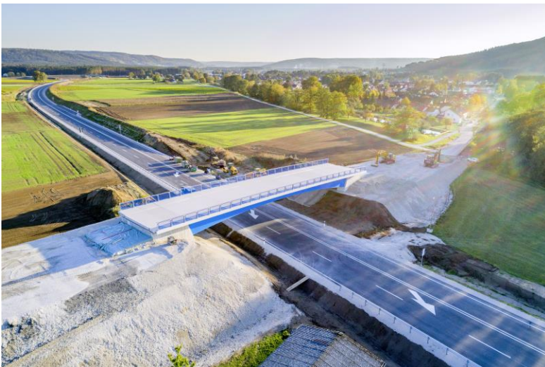
Segmentbrücke Bögl Bildnachweis: Firmengruppe Max Bögl / Segmentbrücke
