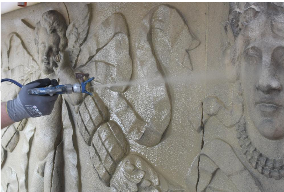
Clean Galena kann im Spritzverfahren großflächig aufgetragen werden.
