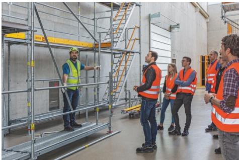
Brennpunkt aktuelle TRBS 2121-1. Hier wird die vorlaufende, zweiteilige Geländermontage in der Modulbauweise mit Vertikalstiel vorgeführt. (Foto: PERI GmbH)
