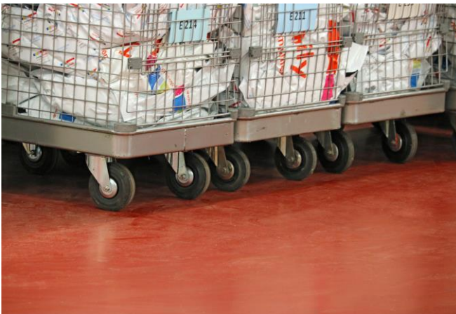
1373 – 2 Abrieb durch Rollwagen.jpg
