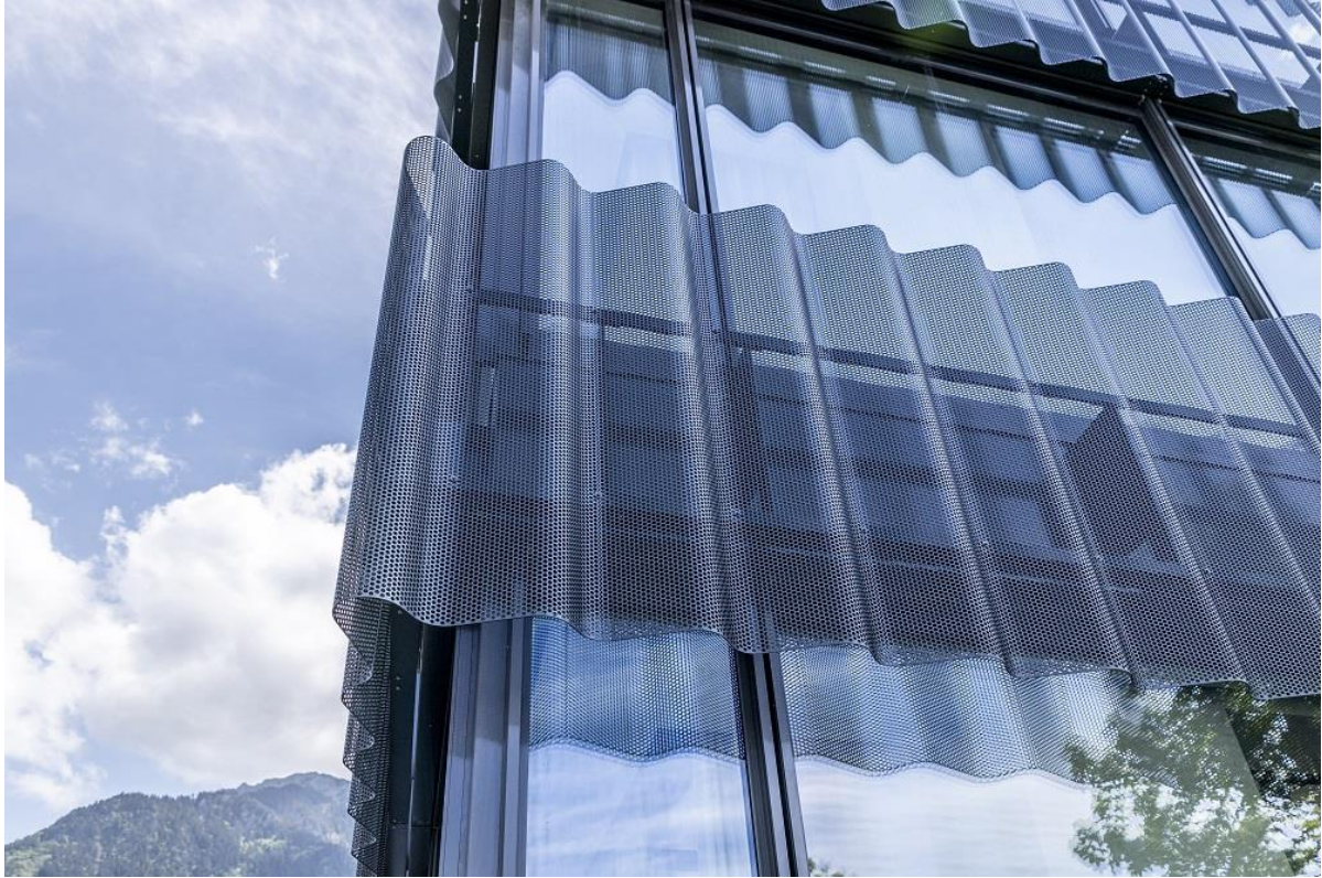
Detail: Umlaufende Ecklösung Bild: metallpfister (CH)
