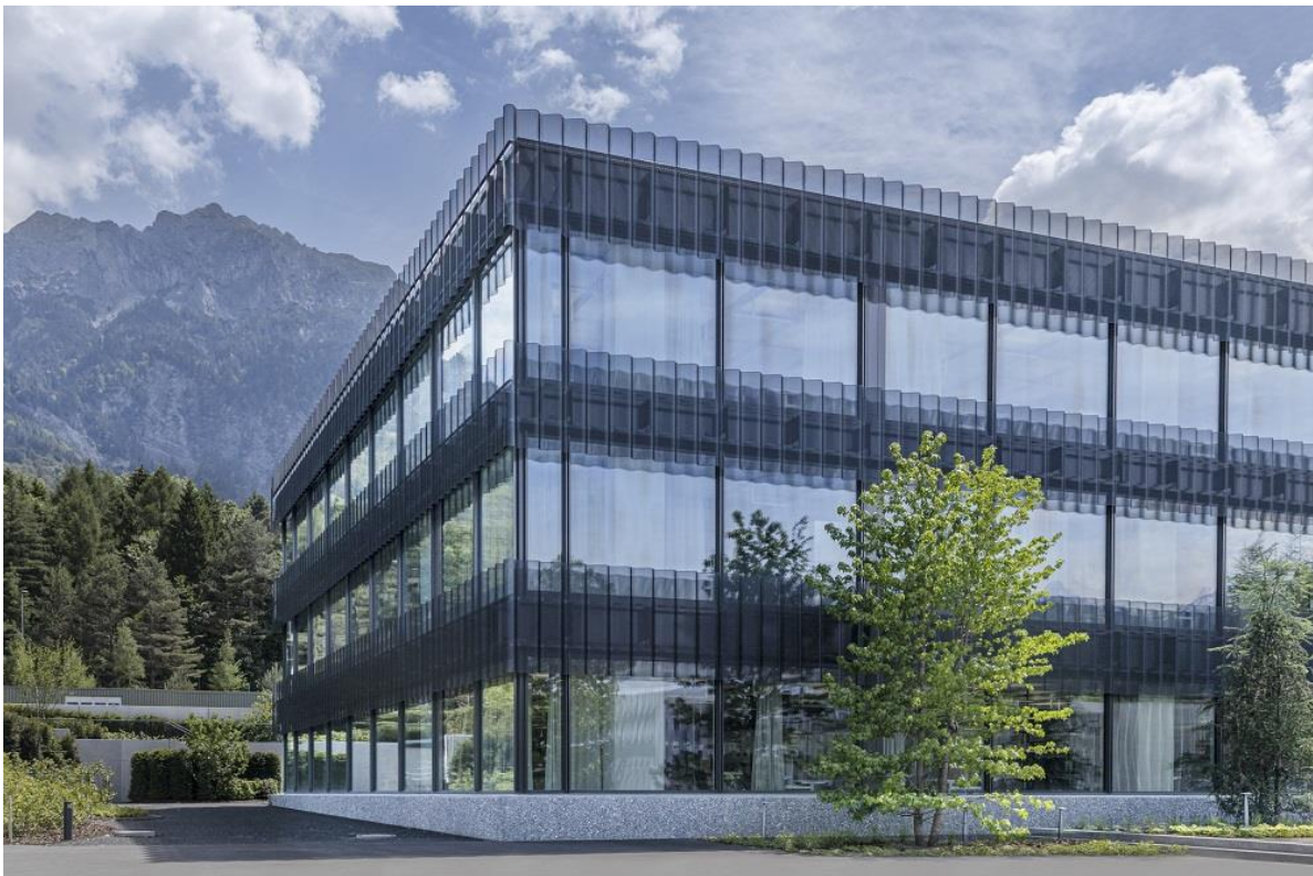
Hilti Bürogebäude in Schaan (LIE), verkleidet mit wellITEC® SW-100/440 Bild: metallpfister (CH)
