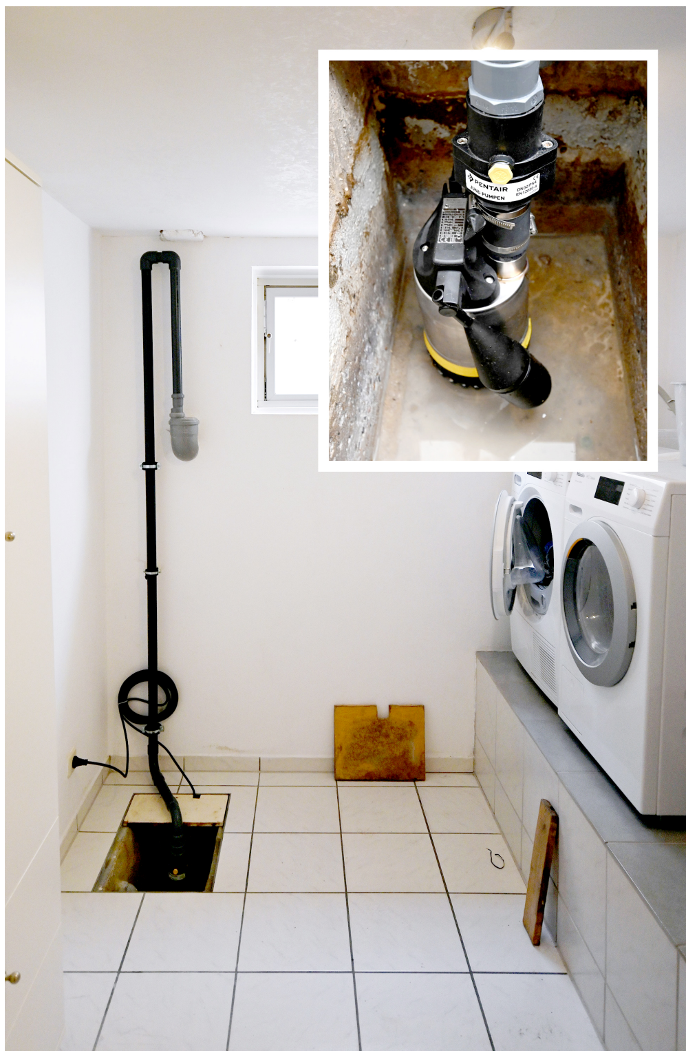
Bild 2: MultiDrain UV3 S Schmutzwasserpumpe für die Entwässerung eines Waschkellers
