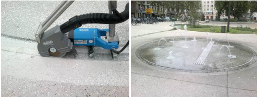
Bild Nr. 01-10 + b OB_Strassburg.jpg Mit E-Werkzeugen der OTTO BAIER GmbH gefräste Nut als Stopp-Signal für Sehbehinderte rund um einen Brunnen am Bahnhofsplatz in Straßburg.
