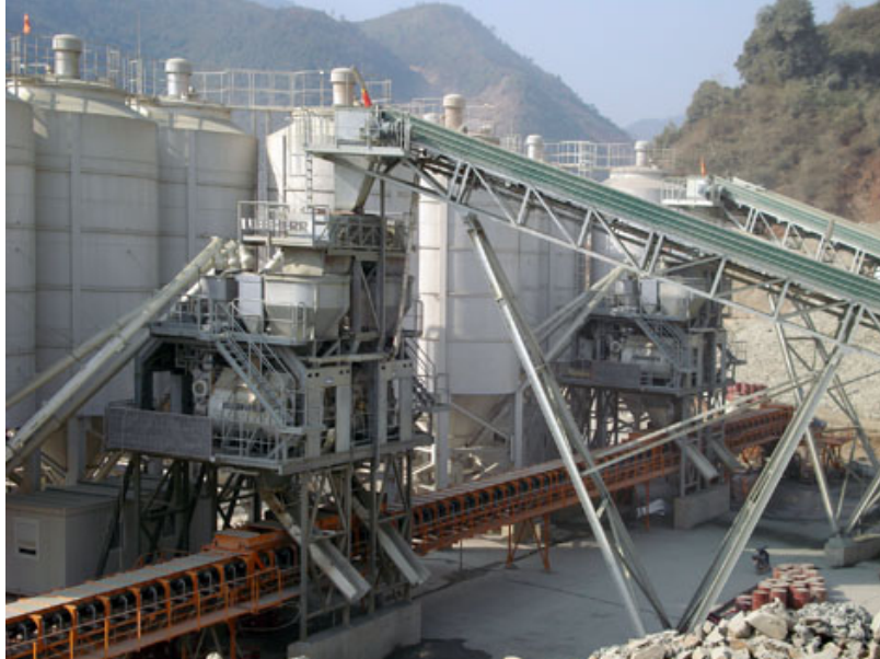
Bild Nr. 17-01 BT_LH-BetonmixAnlage.jpg.
