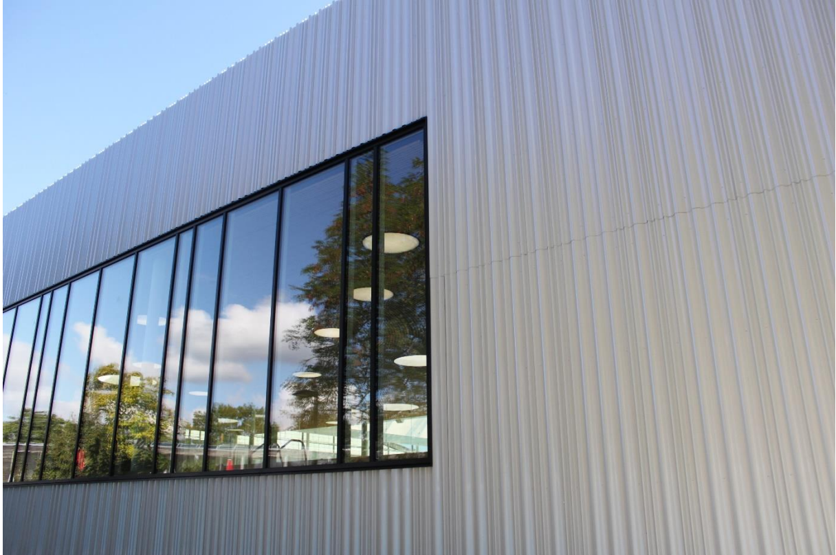
Fächerbad Karlsruhe (DE), wellITEC® vario SW-45/60-45/150 Bild: MN Metall
