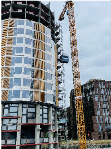
Kaktus-Türme Rohbau mit GEDA Multilift P22 und GEDA 2 PK
