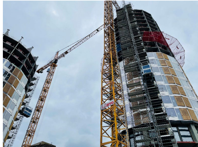
Kaktus-Türme Rohbau mit GEDA Multilift P22, GEDA 500 Z/ZP und GEDA 2 PK
