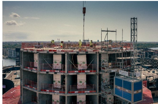
Kaktus-Türme Rohbau mit GEDA Multilift P22
