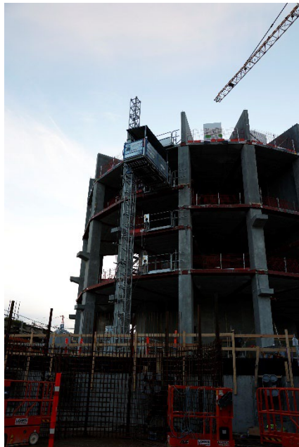
Kaktus-Türme Rohbau mit GEDA 1500 Z/ZP
