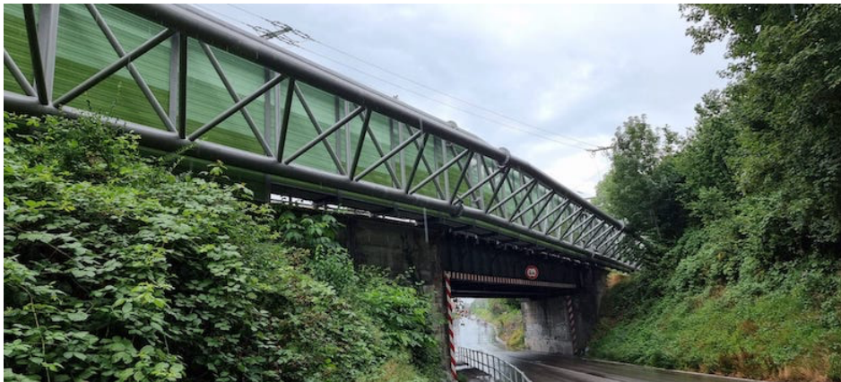
Bild Nr. 13-02 WP_KP-Lärmschutzwand-Lindau.jpg
